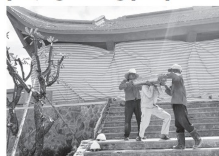
Công nhân tháo dỡ đền thờ xây dựng không phép
