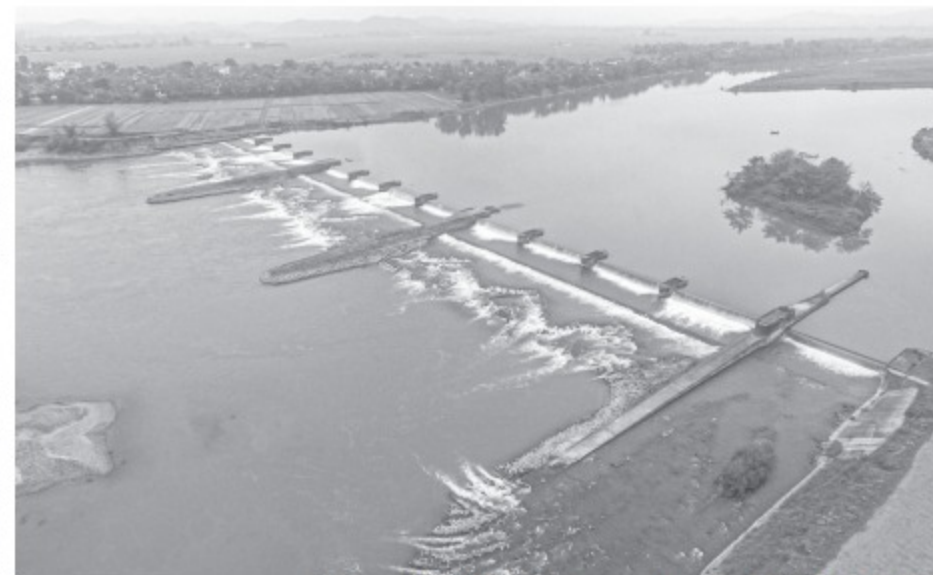
Bara Đô Lương, công trình chặn dòng sông Lam để nước tự chảy vào hệ thống kênh đào ANH: TƯ LIỆU
