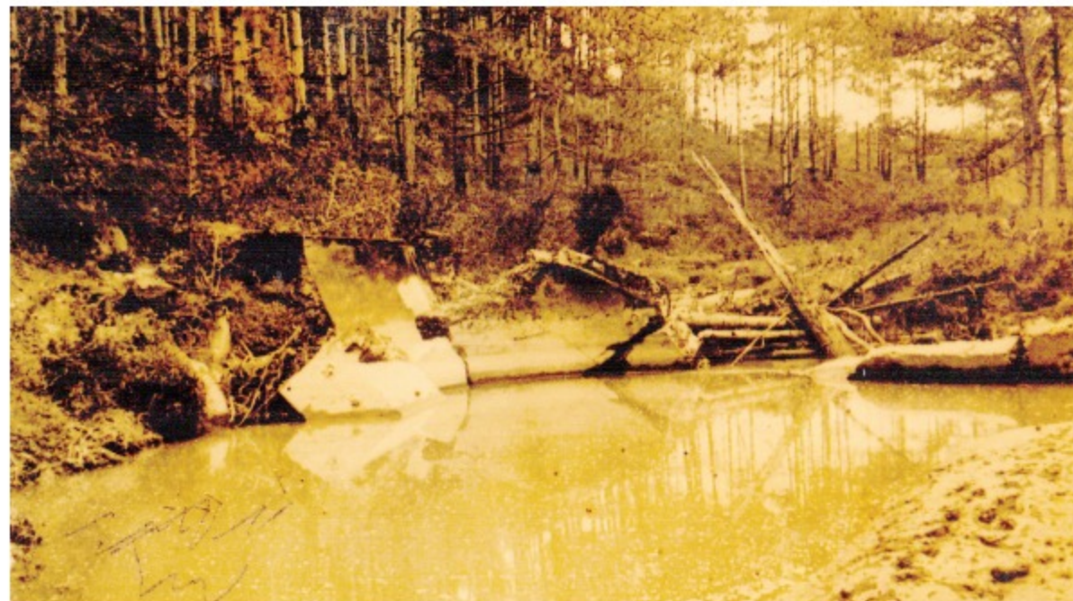
Đập nước nông trại O'Neill bị xé vỡ sau trận lũ ngày 4.5.1932
