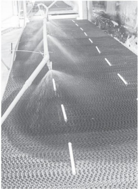
Hệ thống phun nước làm mát trang trại
