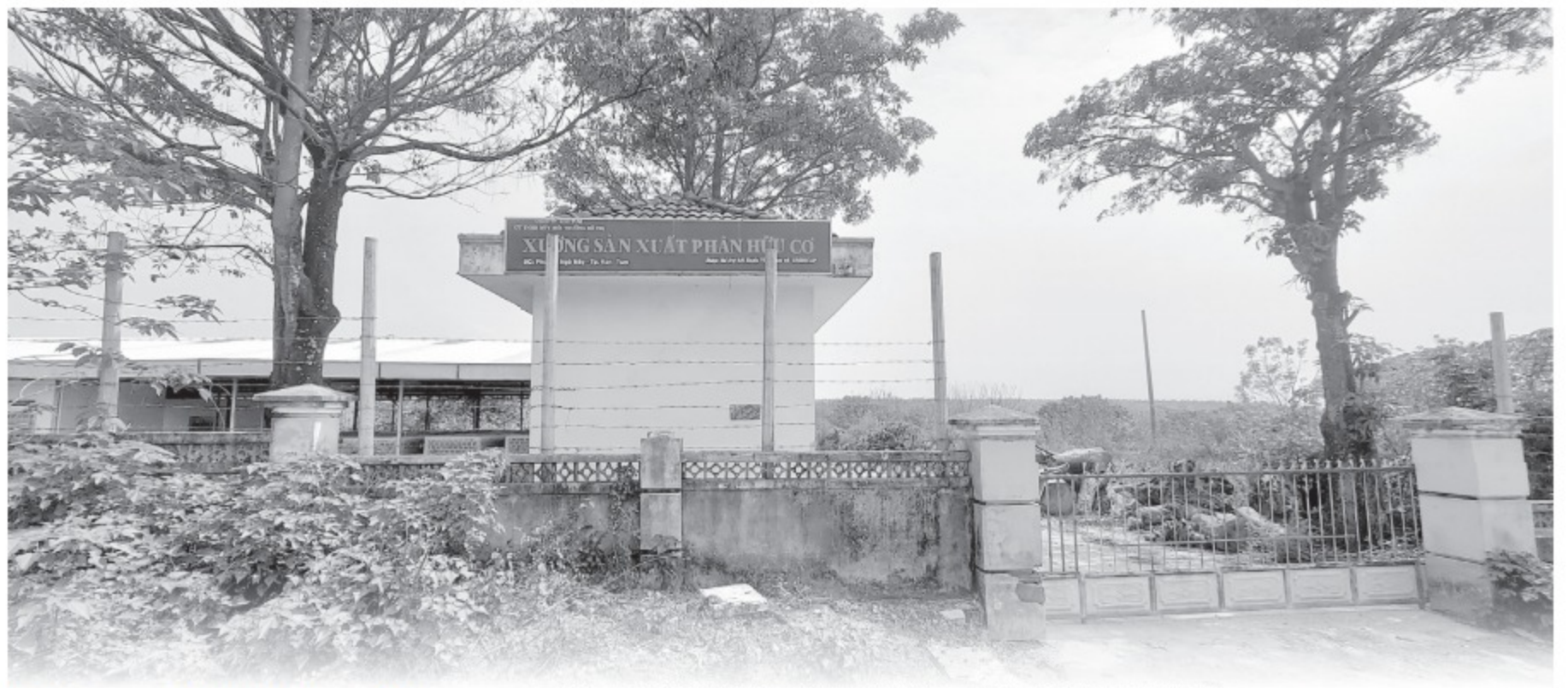
Dự án sau khi đi vào sử dụng được 2 năm thì dừng hoạt động
