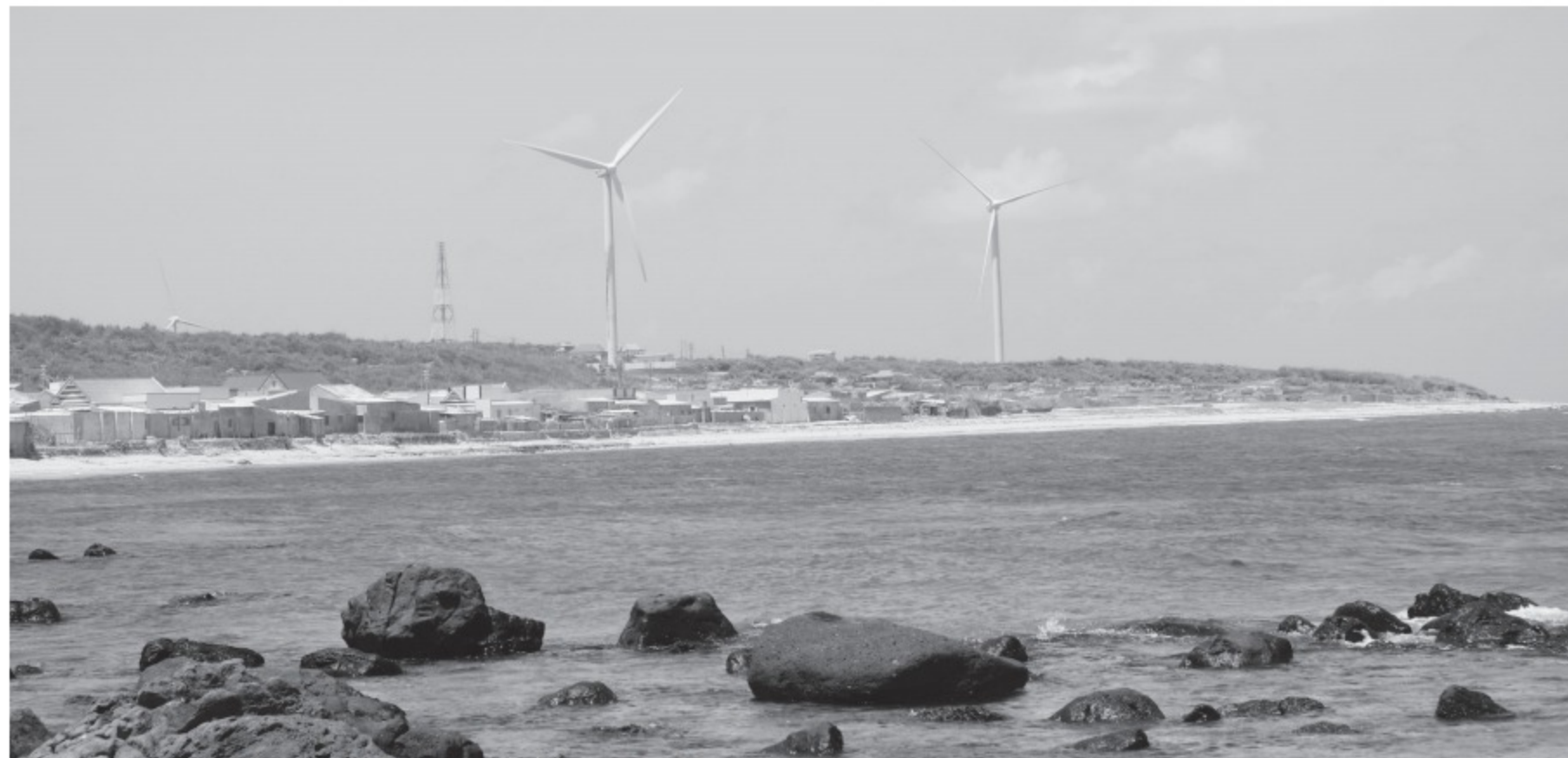
Dự án điện gió trên đảo Phú Quý, Bình Thuận
