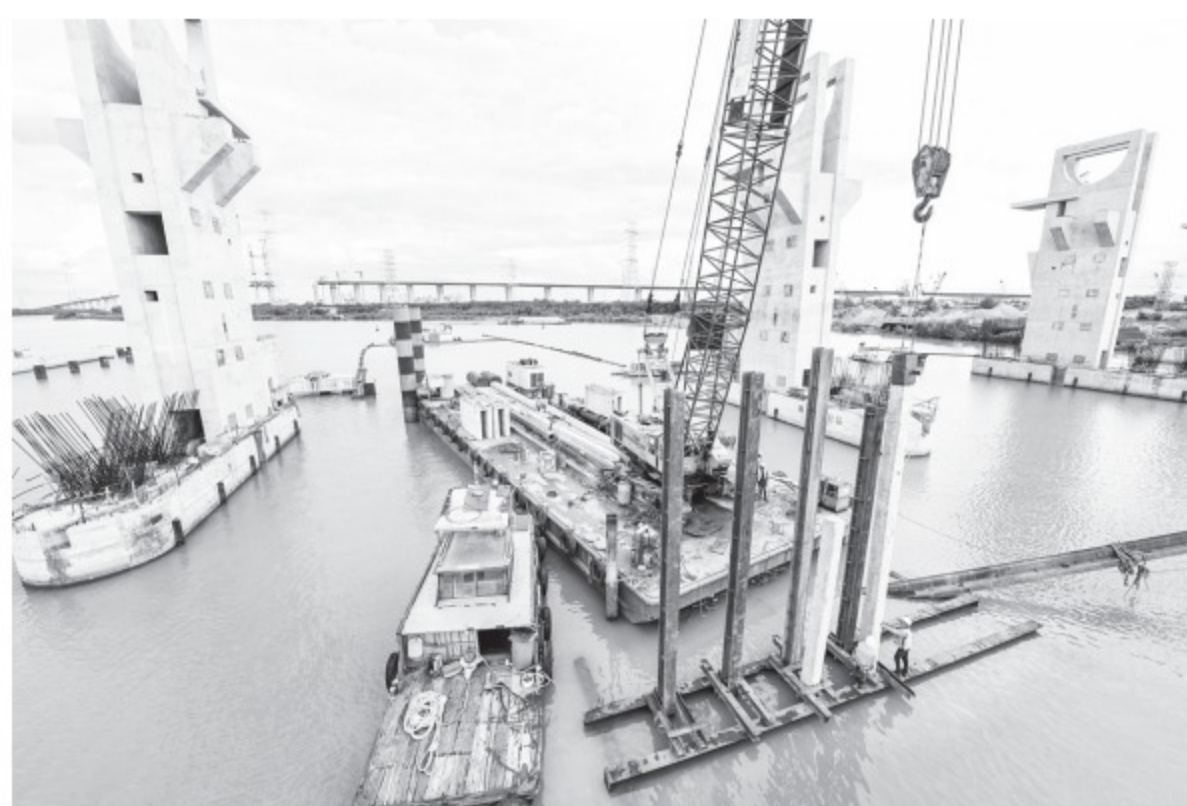
Cống Mương Chuối (H.Nhà Bè), thuộc dự án chống ngập 10.000 tỉ đồng tại TP.HCM
