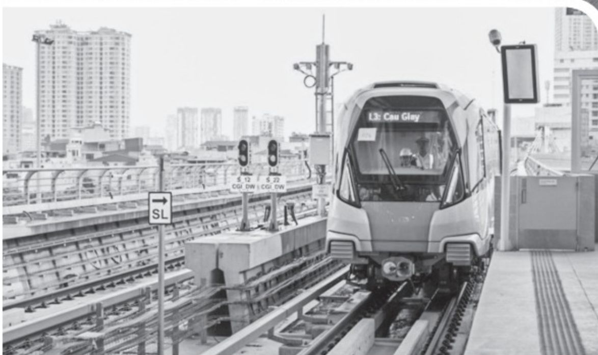
Dự án đường sắt đô thị Nhổn - ga Hà Nội là một trong những nút thắt lớn chậm tiến độ giải ngân của thành phố ẢNH: MRB HN
