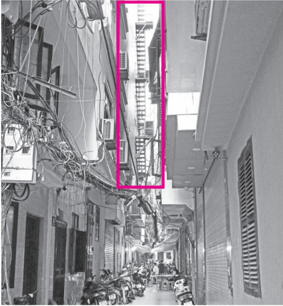
Chiếc thang thoát hiểm... không nổi xuống đất tại một cơ sở karaoke ở Hà Nội ẢNH: KIẾN TRẦN
