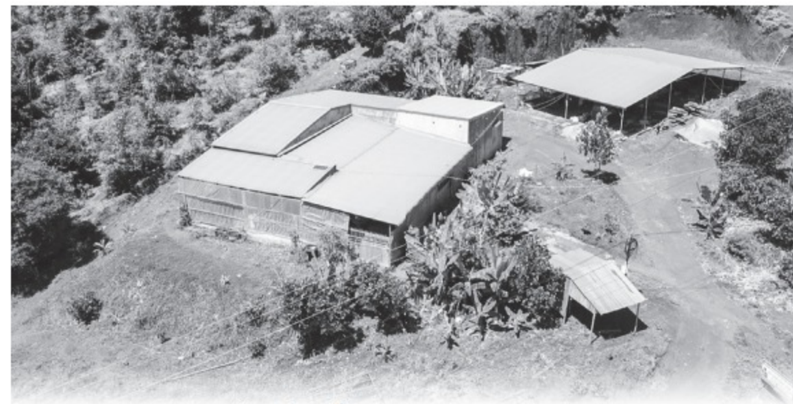
Trên một thửa đất cấp sổ đỏ không đúng quy định ở xã Đắk Som, người dân đã xây dựng nhà
