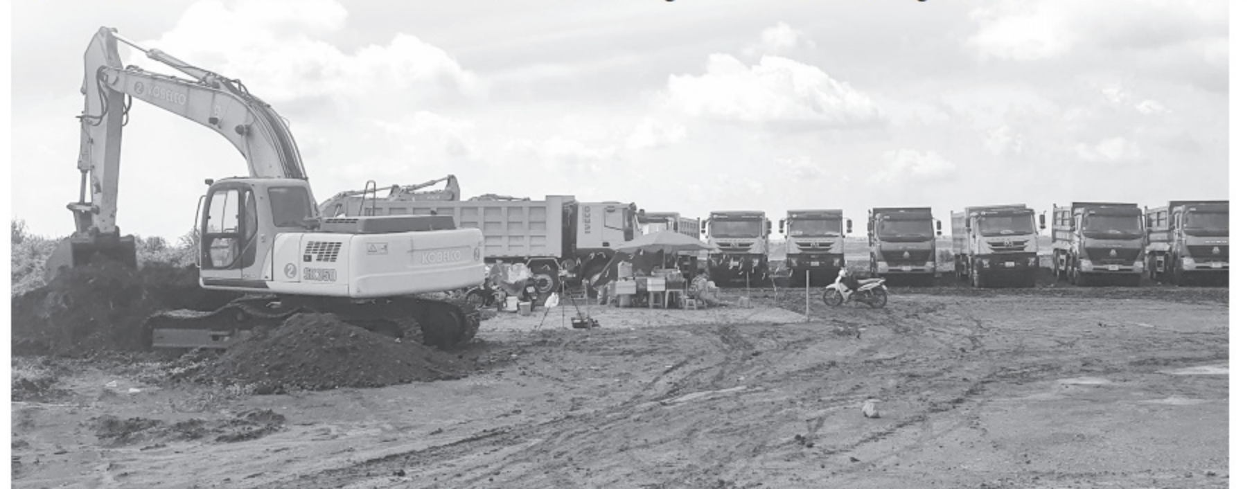
Thời tiết mưa gió khiến phương tiện xe máy tạm ngừng hoạt động tại công trường xây dựng sân bay Long Thành, ngày 19.7.2022
