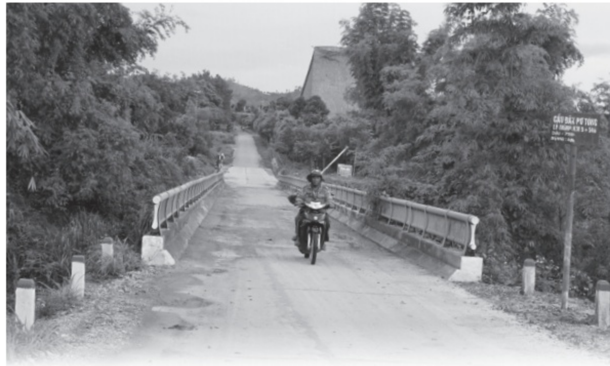
Cầu Đăk Pơ Tong do Công ty cao su Chư Păh đầu tư xây dựng
