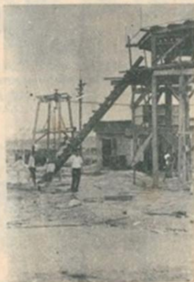
MÁY NƯỚC ĐỦ CUNG CẤP CHO CẢ LÀNG .
