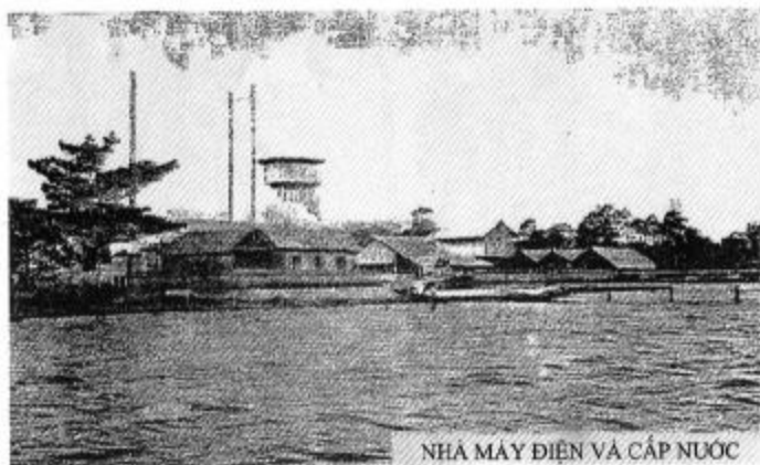
NHÀ MÁY ĐIỆN VÀ CẤP NƯỚC
