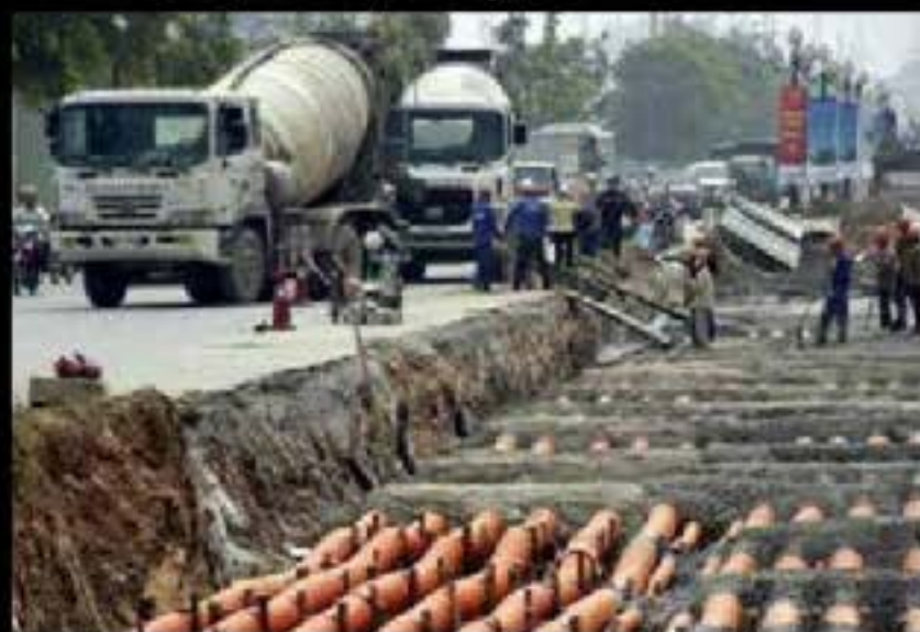
Hình 2: Thi công hạ ngầm các đường dây, cáp bằng phương pháp chôn trực tiếp - Nguồn: Tác giả
