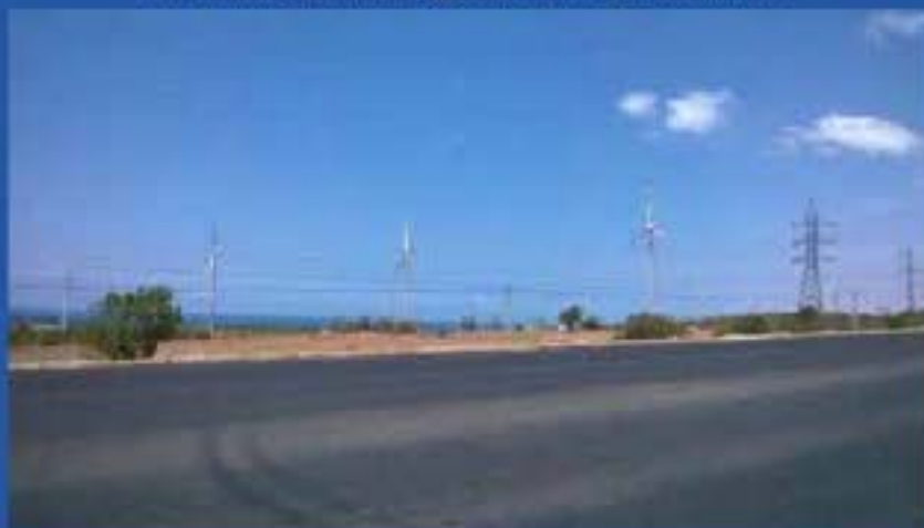
Quạt gió tạo điện năng tại Ninh Thuận
