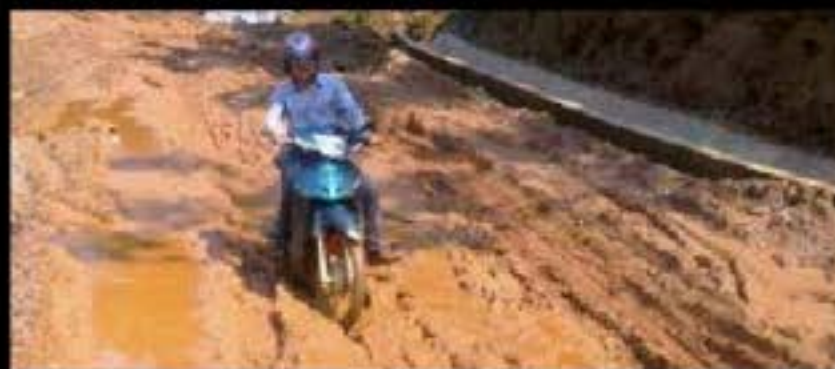
Mưa lớn gây sạt lở một số tuyến đường thuộc các xã TP Lào Cai (Nguồn UBND Thành phố Lào Cai)
