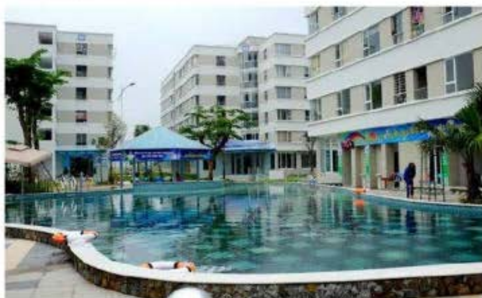
Bể bơi tại khu NCXH Đặng Xá.
