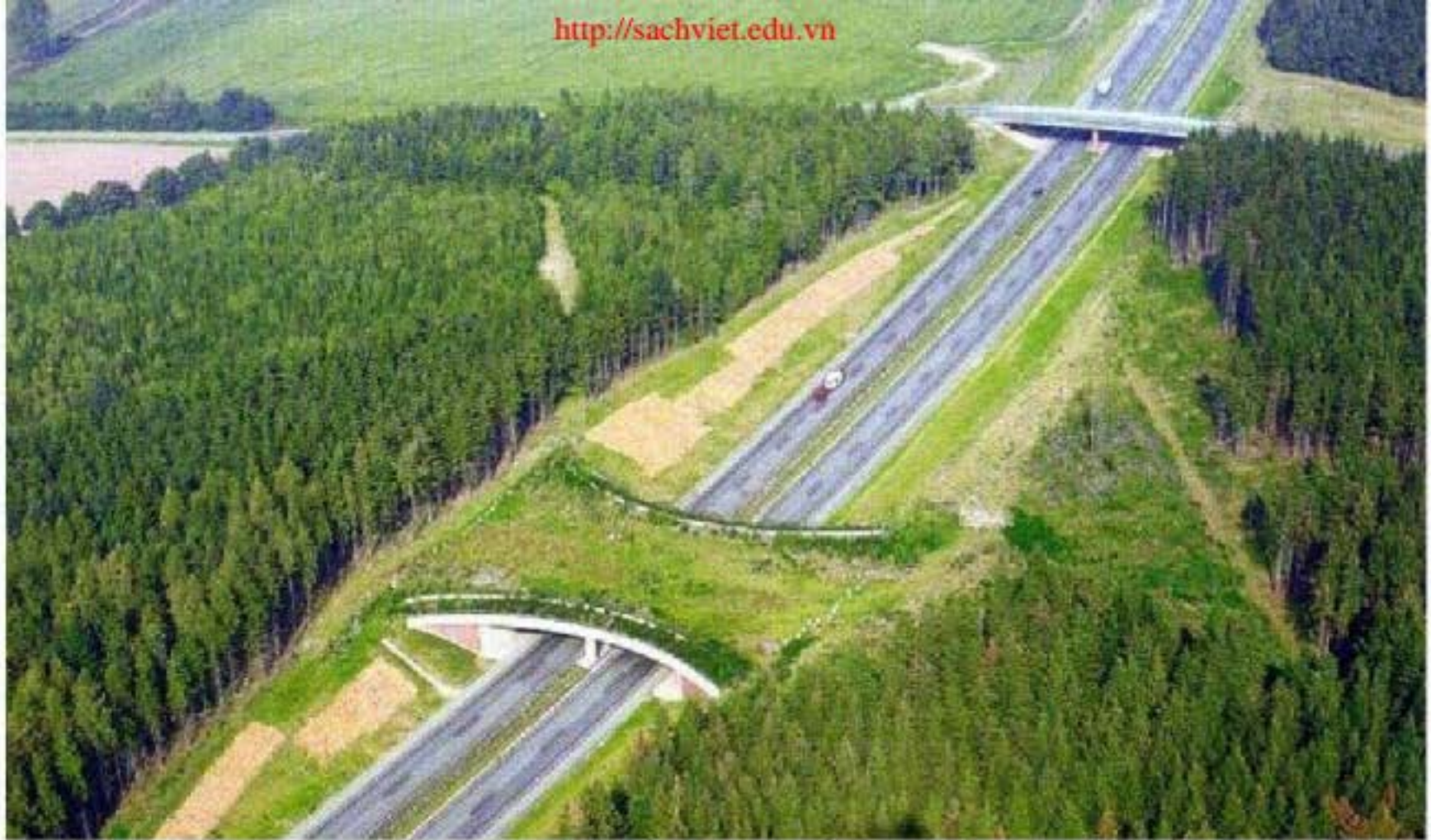
3. Cầu Xanh (Green bridge) trên đường A20 gần Grevesmühlen - Đức
