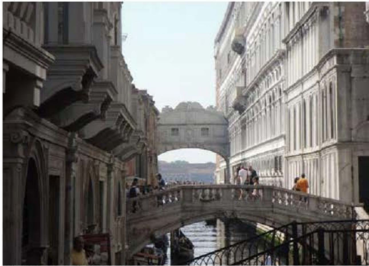
Cầu Than thở (Ponte dei Sospiri) – Ý
