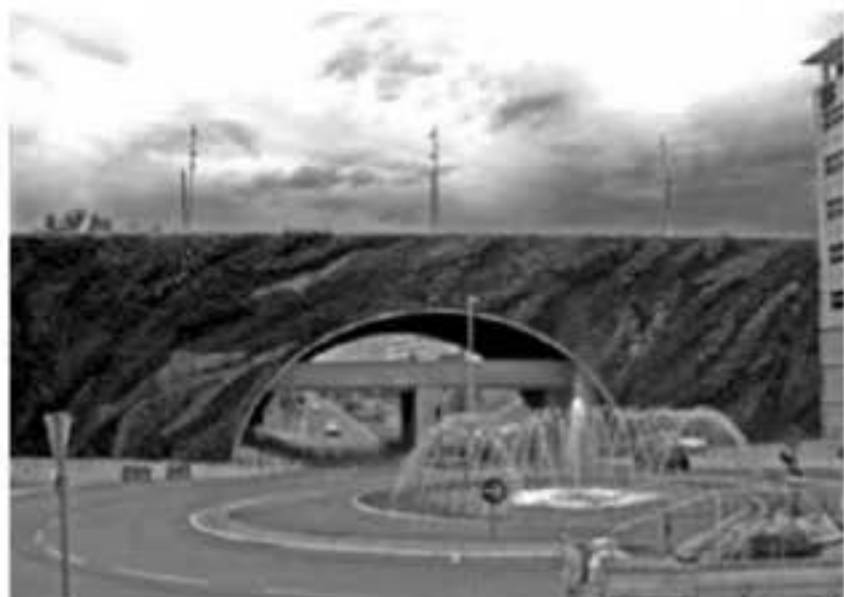
Khu vườn Pont Max Juvenal, Provence, Pháp có kết cấu gồm ba phần: lớp khung kim loại, lớp polymer vinyl chống thấm cho bê tông và một lớp tích nước để nuôi cây. Công trình thiên nhiên này đã làm cho cây cầu bê tông khô trở nên xanh tươi rất thích hợp cho các khu đô thị hiện nay. (Nguồn: Internet)
