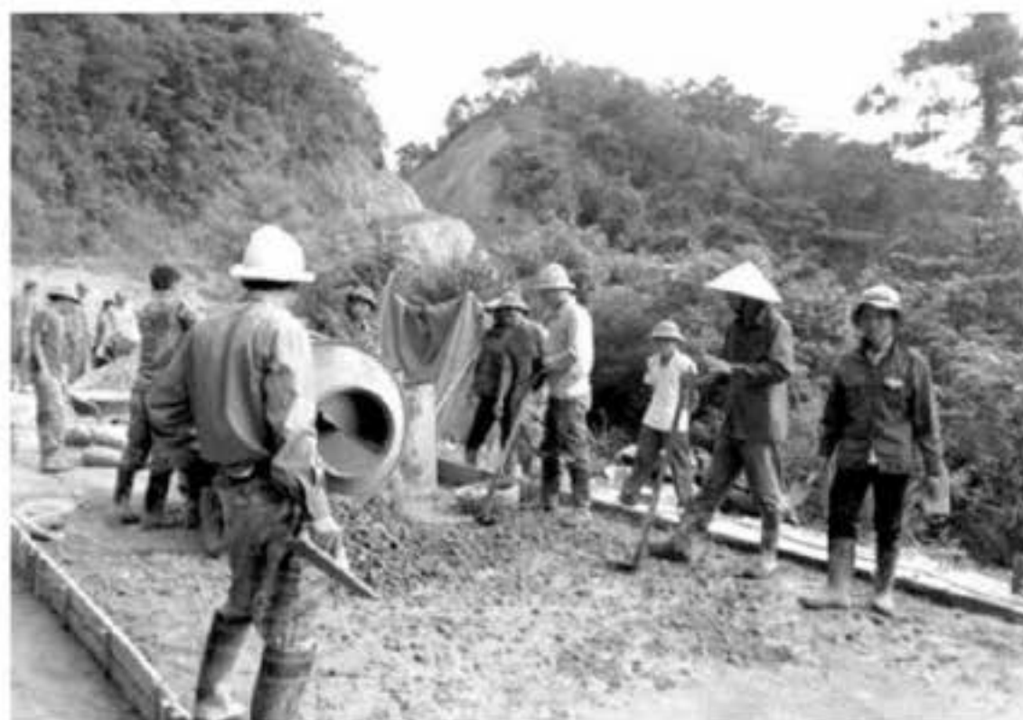
Hoàn thành bê tông hóa trên 95% đường giao thông ngõ xóm
