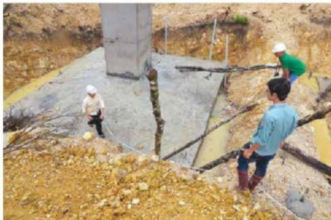
Đo đạc, kiểm tra các trụ bê tông trên đảo
