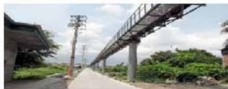
Tuyến băng tải ống vận chuyển than, giảm thiểu tối đa ô nhiễm môi trường.
