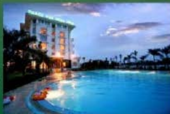
Khu bể bơi
