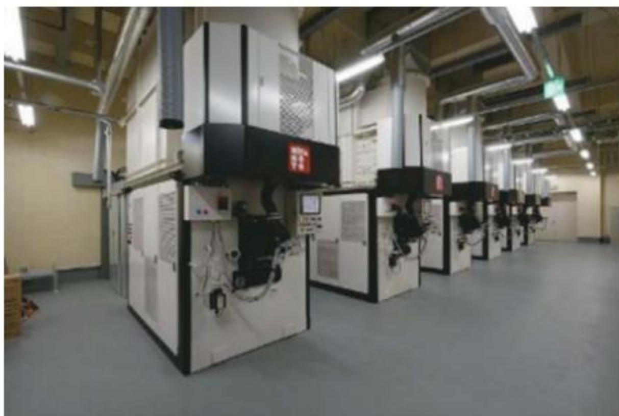
Hình 7: Hệ thống lò hỏa táng với thiết bị xử lý khí thải hiện đại của Nhật Bản
