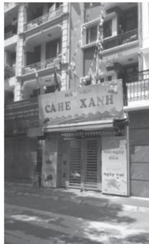
Hình 6b: Đường phố ở khu Yên Phúc 2 được quy hoạch khá tốt, vỉa hè hẹp, ít cây xanh
