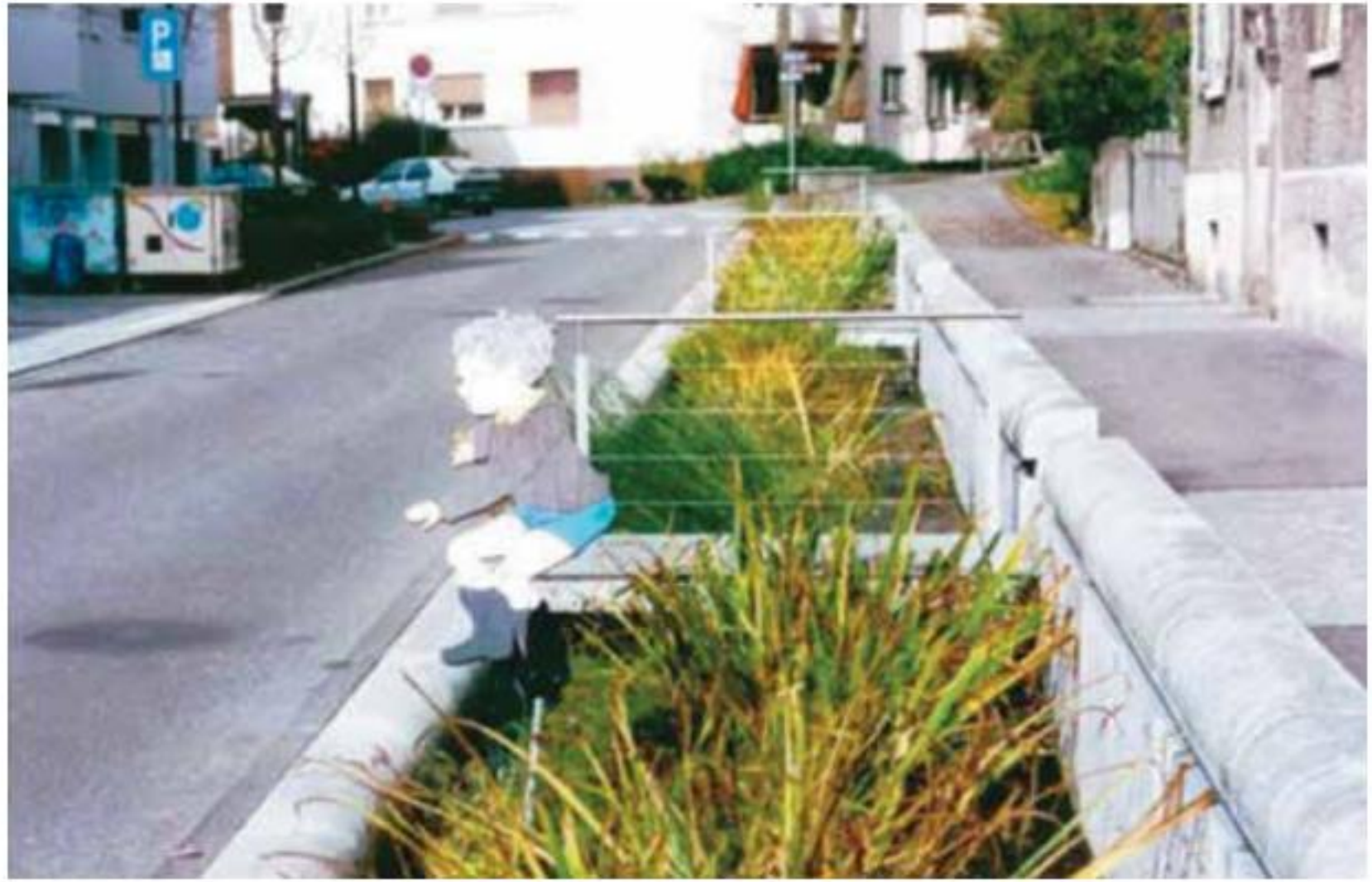
Hình 3. Giải pháp sử dụng cây xanh lọc cống trên các đường phố Thụy Điển (Nguồn: http://www. Bookfi. Org )
