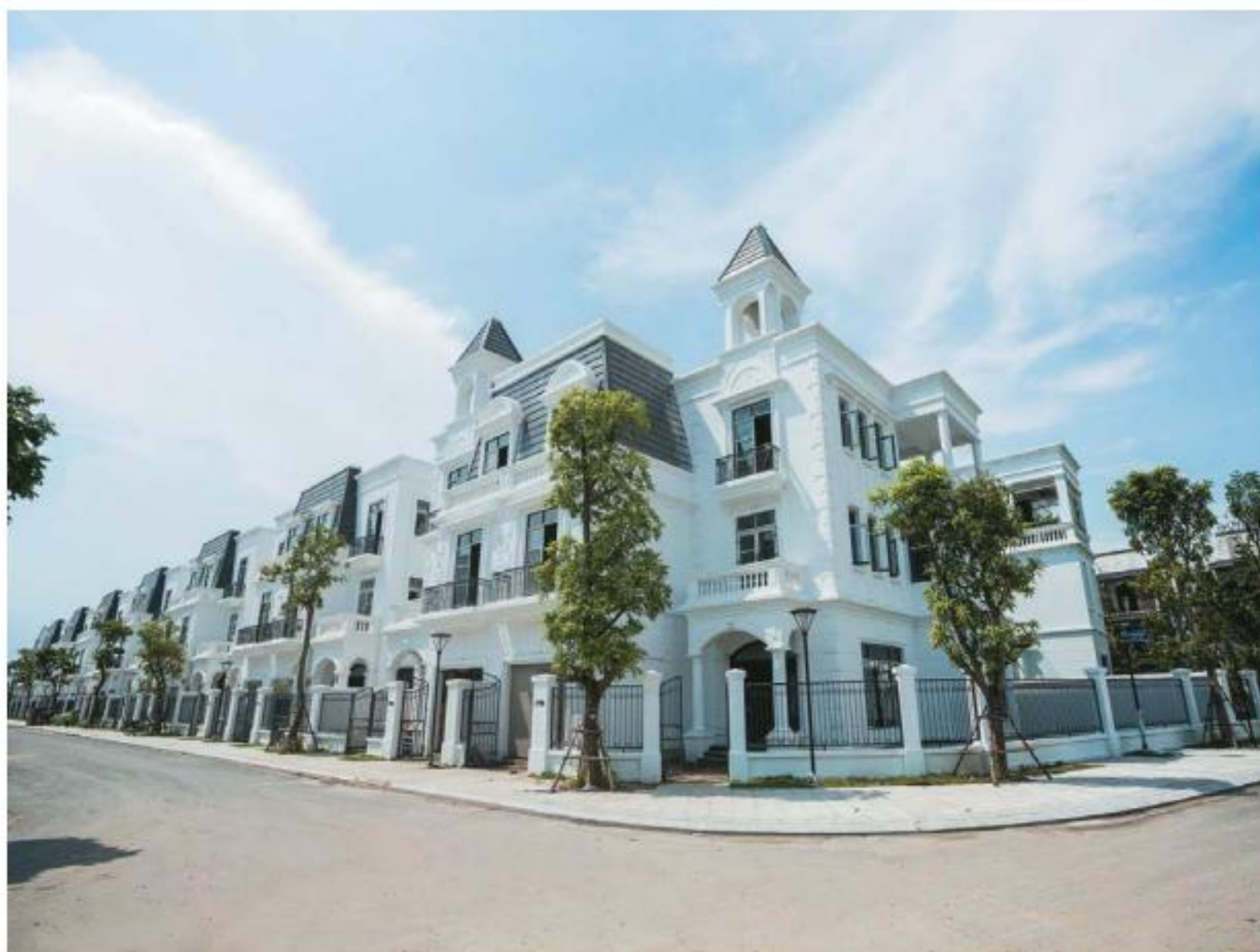
Ảnh thực tế tiến độ thi công phân khu The Paris với hầu hết căn biệt thự đã được cất nóc
