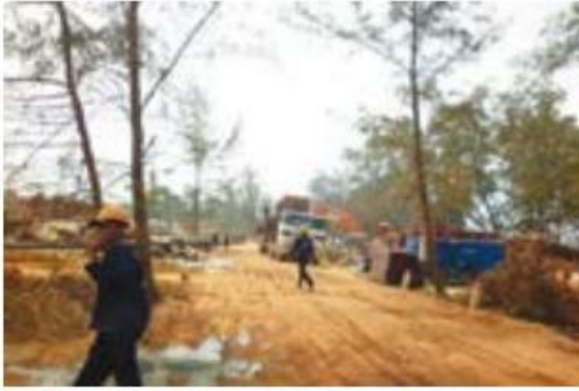
Tuyến đường mới ven biển đang thi công
