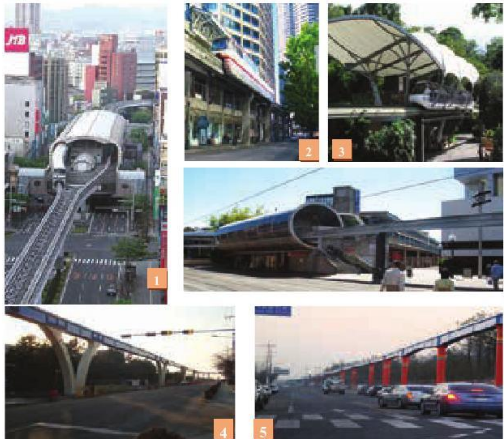
Hình ảnh - 23: Kết cấu cột đỡ, đường ray dẫn hướng và nhà ga tàu điện một ray tại các nước trên thế giới
