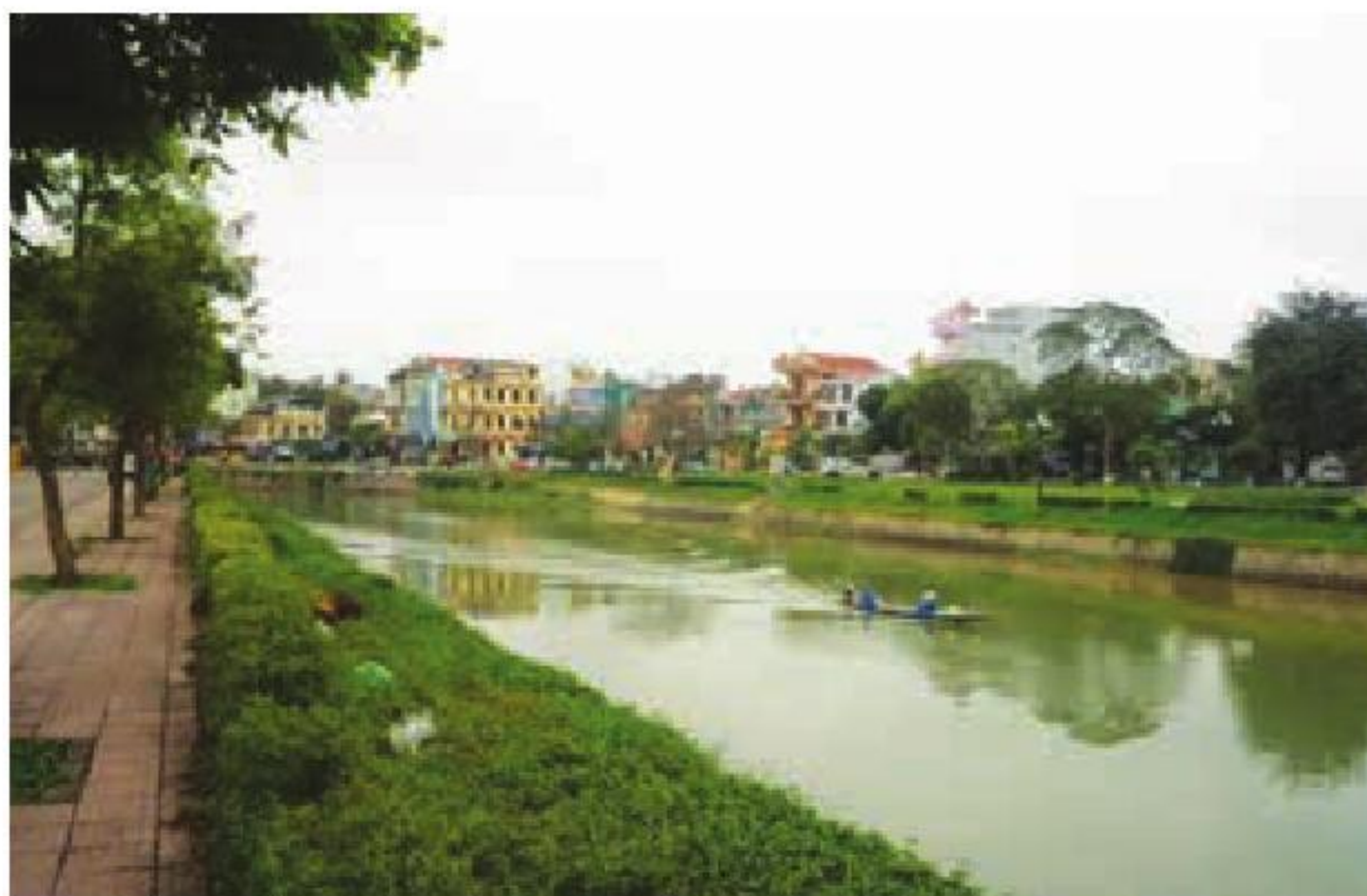
Sông Ngự Hà vừa được chỉnh trang. Nguồn: congdongxaydung.vn
