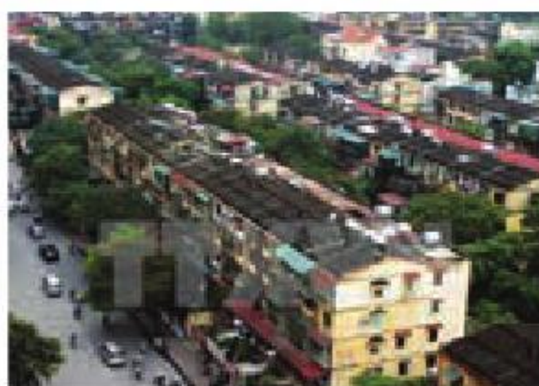
Một góc khu tập thể Trung Tự (quận Đống Đa), một trong các khu tập thể cũ, chất lượng đã xuống cấp. (Ảnh: Tuấn Anh TTXVN)
