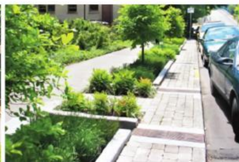
Bồn trồng thực vật kết nối với hệ thống thoát nước đường phố nhằm giảm tải cho năng lực thoát nước của hệ thống hạ tầng hiện hữu
