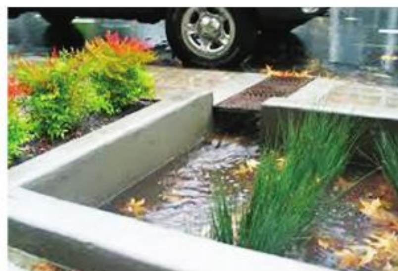
Dẫn nước mưa vào bồn cây đường phố - kết nối với hệ thống hạ tầng hiện hữu
