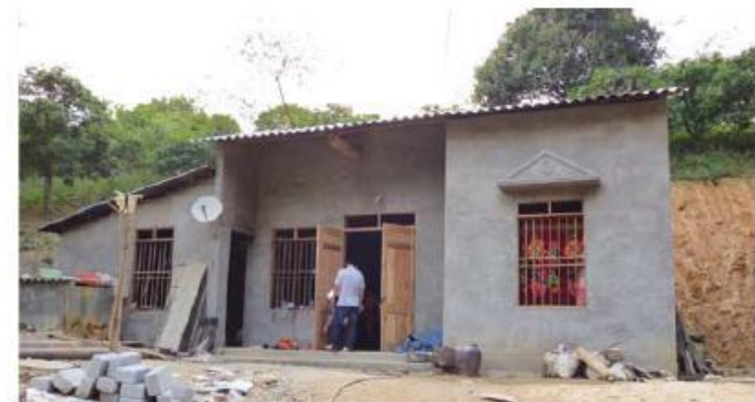
Ngôi nhà khác đã hoàn thành
