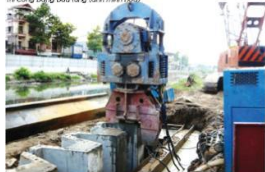
Thi công lắp đặt cử bản (ảnh minh họa)
