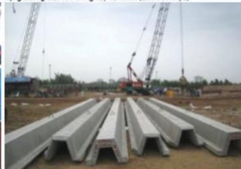
Cọc cử bản bê tông ứng lực trước tại cầu Cá Trê Nhỏ thuộc dự án xây dựng đường cao tốc Đông Tây Sài Gòn. (ảnh minh họa)
