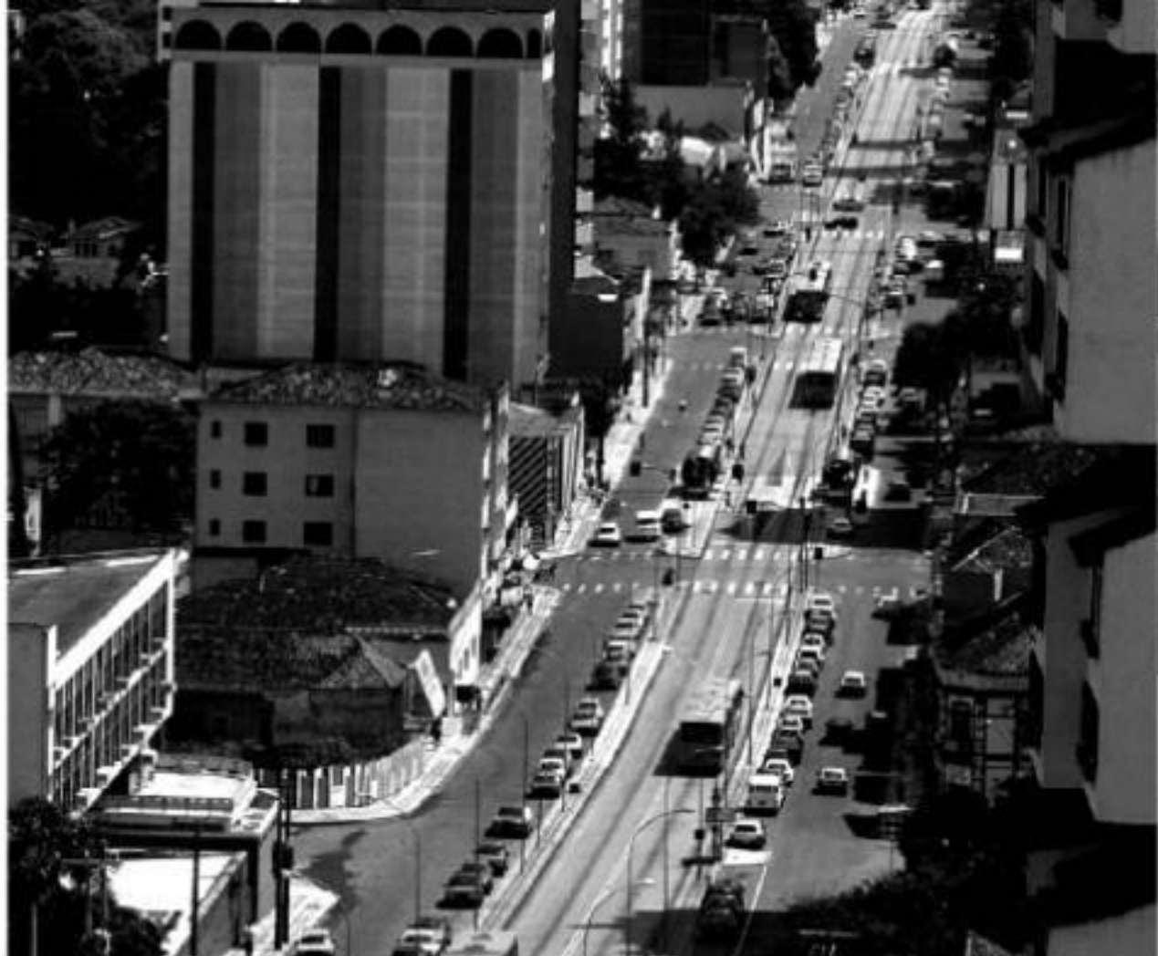
Hình 8: Một góc thành phố Curitiba dọc theo tuyến xe buýt tốc hành nổi tiếng.
