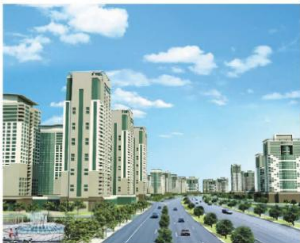
Dự án đường trục Bắc Nam phía Tây Hà Nội dài 63 Km do Tập đoàn Nam Cường làm chủ đầu tư
