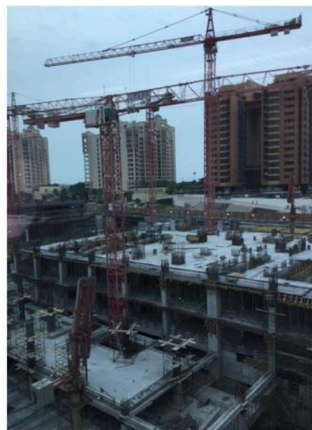
Các nhánh cò vẫn đang xây dựng. Người ta nói 3/4 số cần cầu trên thế giới hiện đang ở Dubai .
