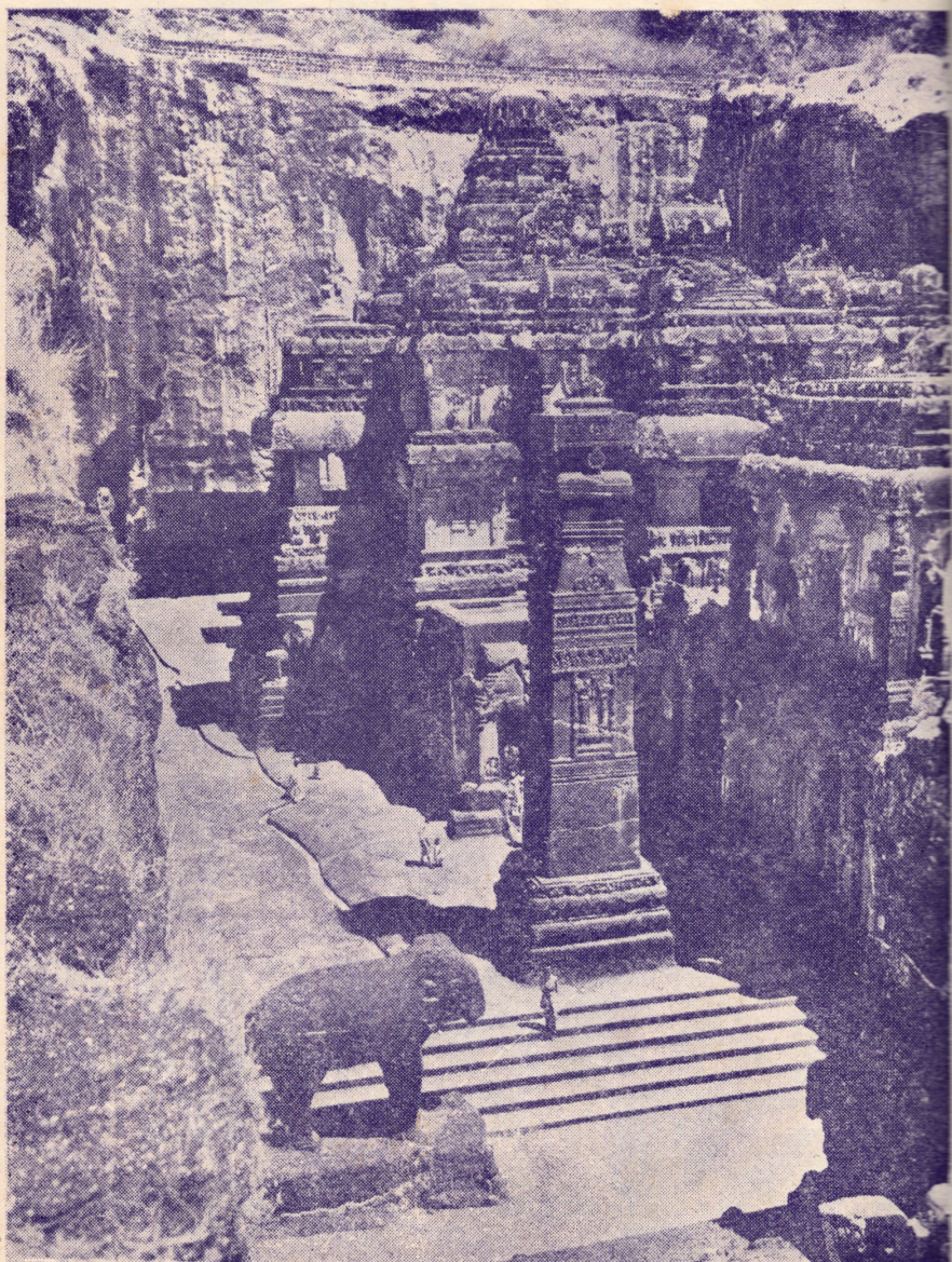
ELLORA : Đền Kailasa Nhìn từ ngoài và từ phía Tây - Bắc
