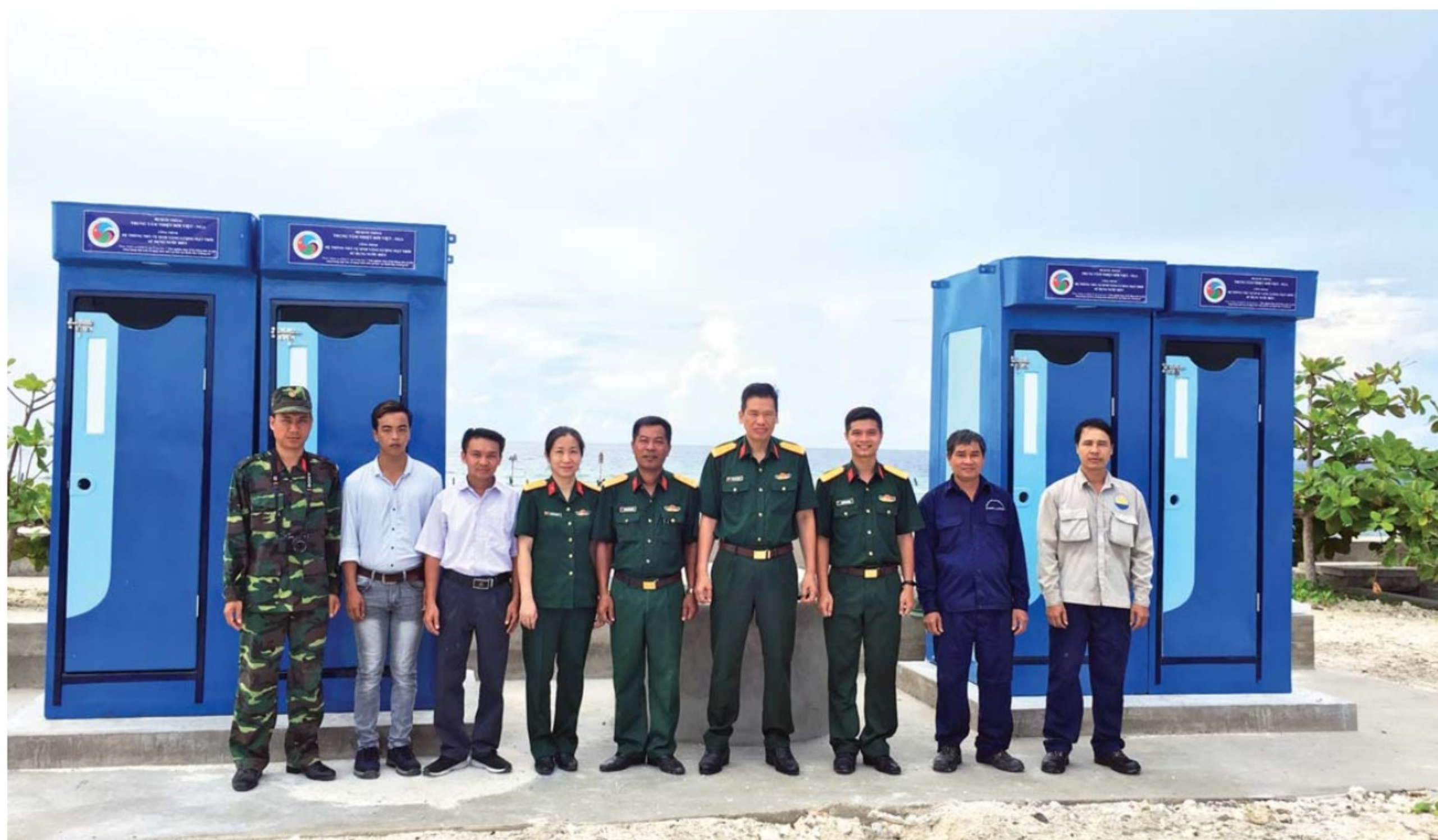
Lắp đặt hệ thống nhà vệ sinh năng lượng mặt trời, sử dụng nước biển tại đảo Đá Tây A
