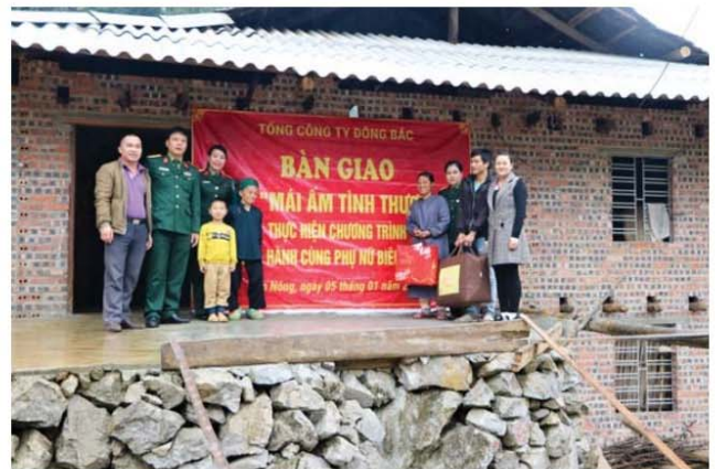
Mừng ngôi nhà mới của chị Hoàng Thị Món, xóm Lũng Rì, xã Cán Nông (Thông Nông, Cao Bằng) vừa được xây dựng
