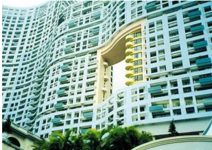
Tòa nhà tại Hong Kong với “lỗi hướng” đón gió.
