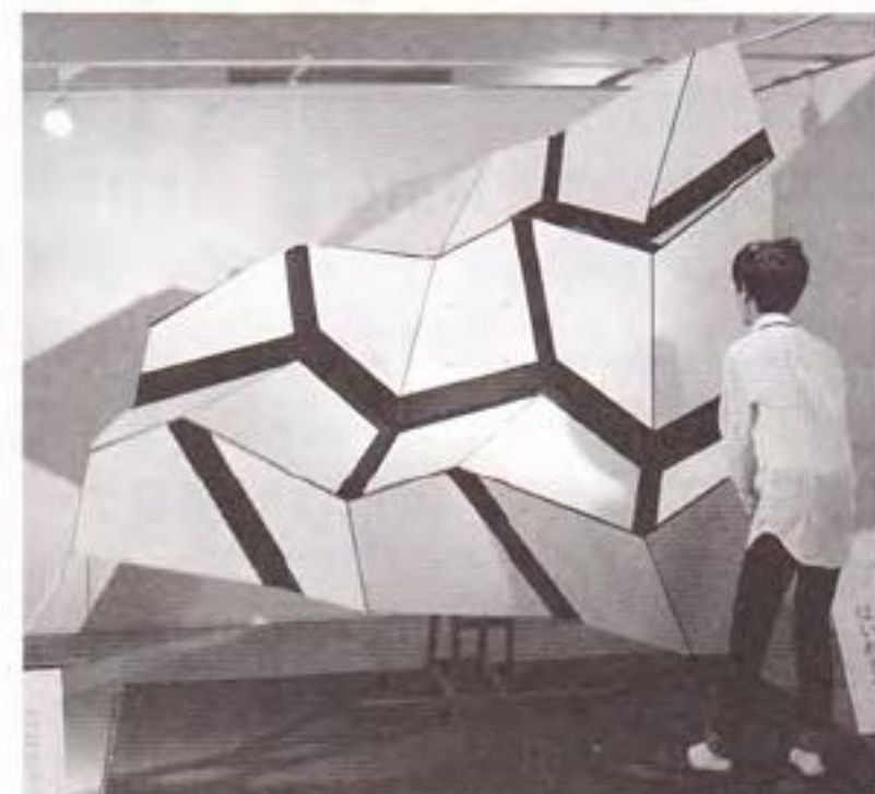
写真9: パネルとヒンジで構成された剛体折紙の壁。軽い力で開閉が可能
