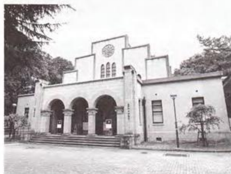
写真1: 駒場博物館。旧制一高の図書館のリノベーション
