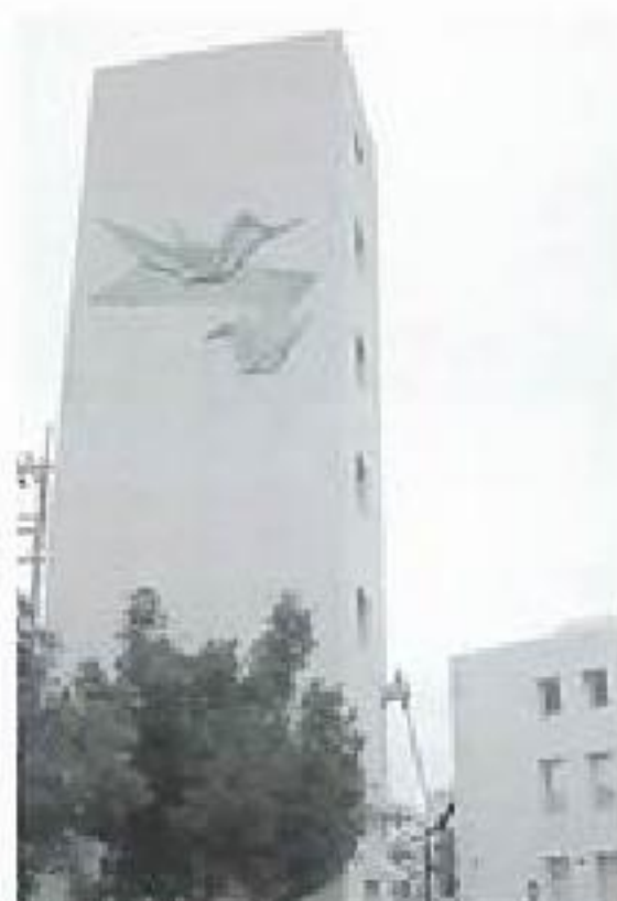
相模原南消防署 上鶴間分署 The Kami-Tsuruma Branch Office of the Sagami-hara-Minami Fire Station
