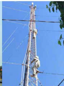
THI CÔNG XÂY LẬP HẠ TẦNG VIỄN THÔNG
