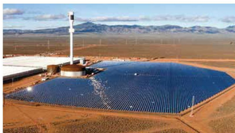
Toàn cảnh Sundrop Farms với bốn khu nhà kính một bên và hệ thống kính hội tụ ánh nắng mặt trời một bên, ở giữa là ngọn tháp cao 127 m với nồi hơi nước năng lượng.
