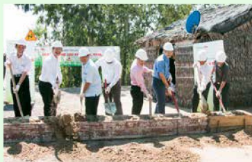
Lễ khởi công 4 công trình cầu - cống tại huyện Vĩnh Hưng, tỉnh Long An. Ảnh: Uyên Lê.
