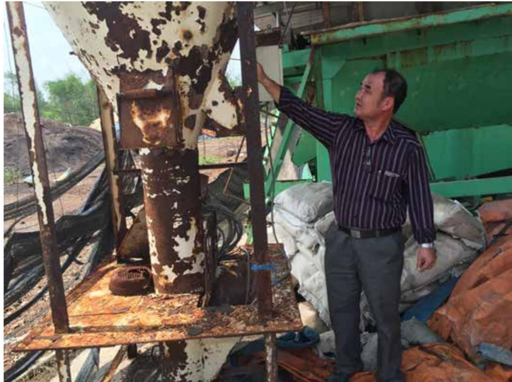
Hệ thống máy móc của Công ty phân bón Thuận Phong bị rỉ sét thành phế liệu sau hơn 1 năm bị niêm phong. Ảnh: L. Long.
