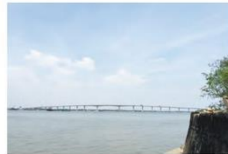
Cầu Mỹ Lợi trên sông Vàm Cỏ (Ảnh: năm 2016).
