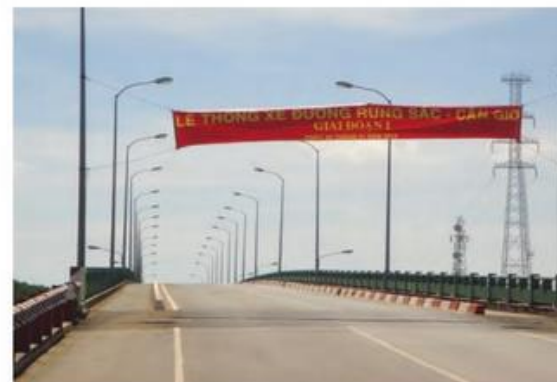
Cầu Dầm Xây với băng rôn "Lễ thông xe đường Rừng Sác - Cần Giờ - giai đoạn 1, ngày 26-01-2010"
