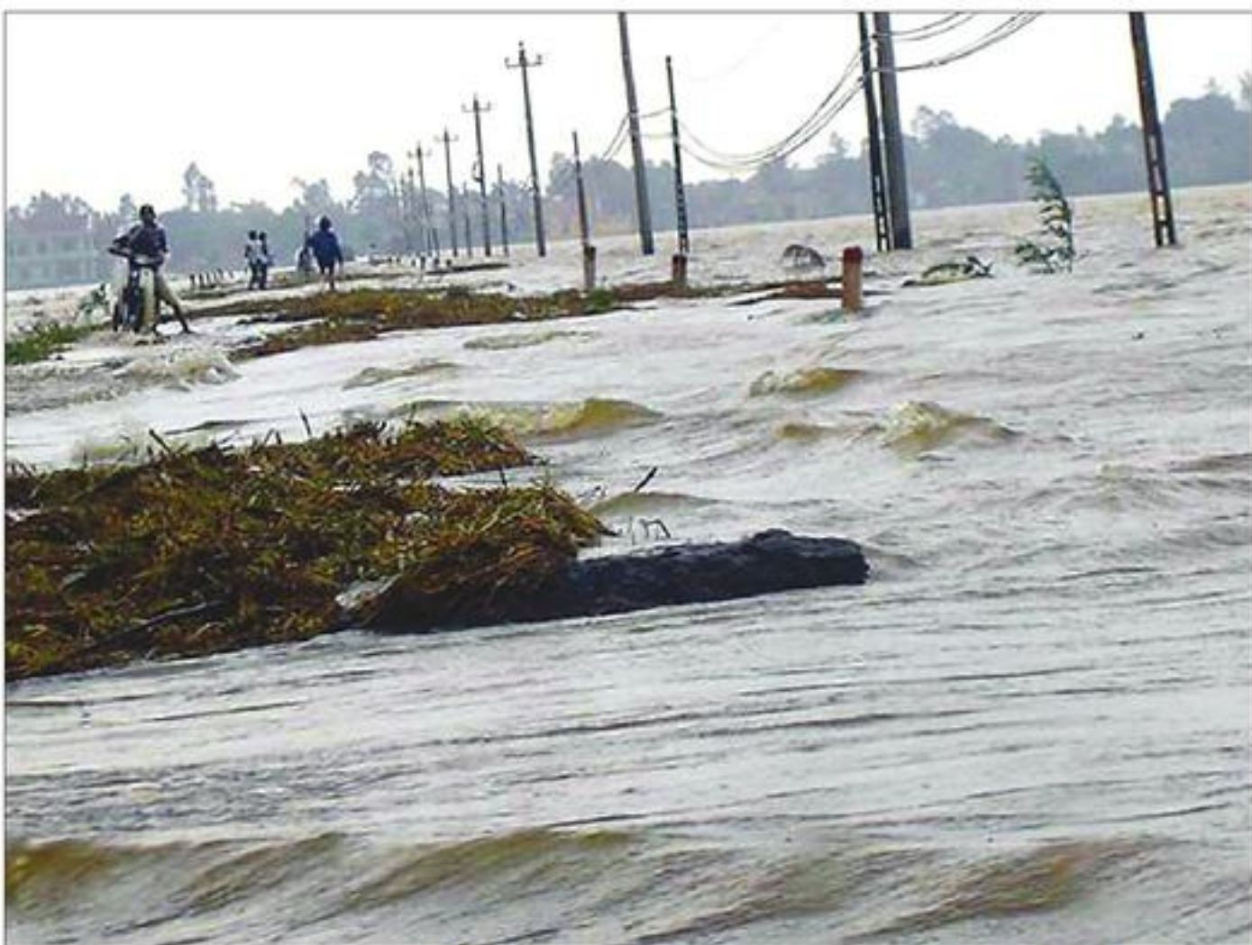
Ngập đường lộ giao thông
