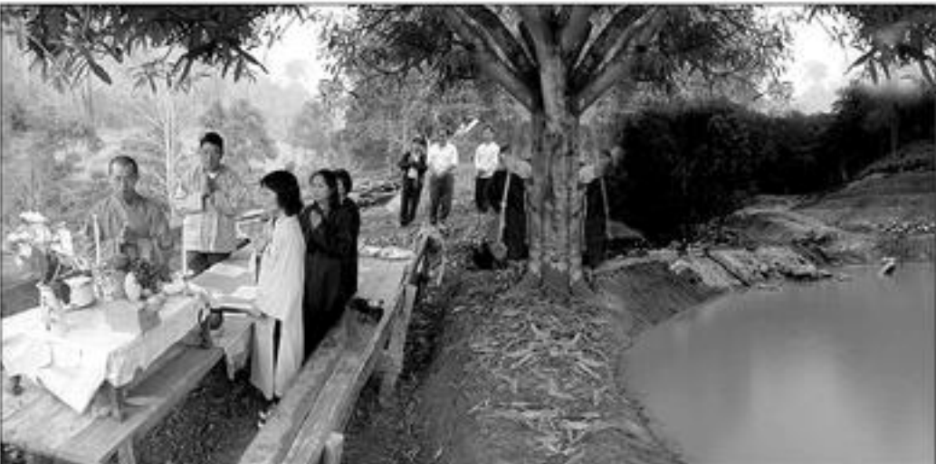
Đại Đức Thích Hạnh Nguyễn cùng các thiện nam tín nữ trong buổi lễ khởi công, đặt móng xây Cực Lạc Giới Tử tại Chiangmai Thái Lan. (Hình Sariputra Educational Foundation).
