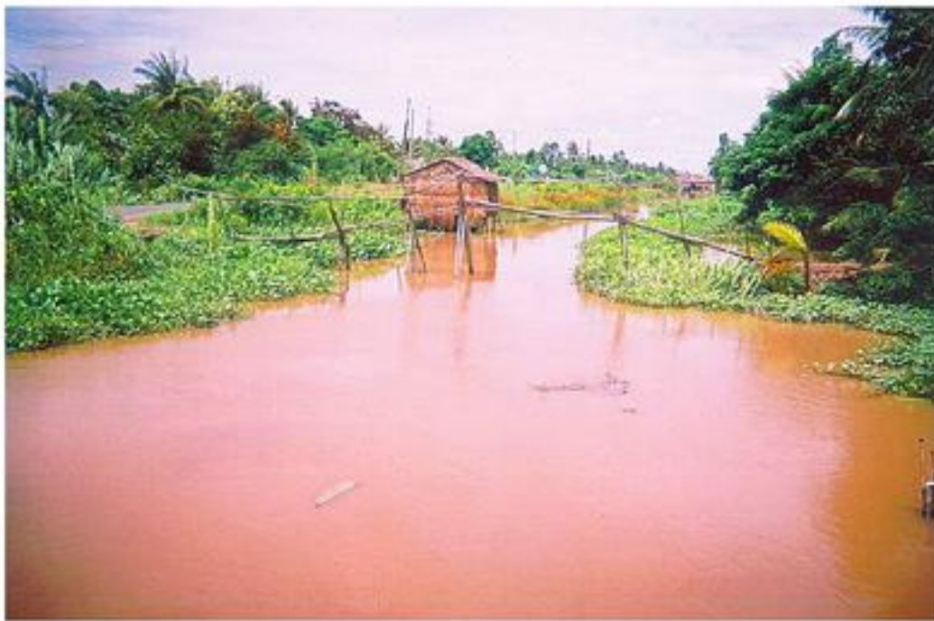
Cầu khỉ còn tồn tại rất nhiều ở vùng đồng bằng sông Cửu Long. Nhà cầm quyền Hà Nội trước đây đưa ra kế hoạch "xóa 1,500 cầu khỉ" vào năm 2005 nhưng đến nay, chúng vẫn còn đó. Chỉ có một số ít cầu khỉ được thay thế bằng cầu sắt, hay cầu xi măng để chụp hình đăng báo.
