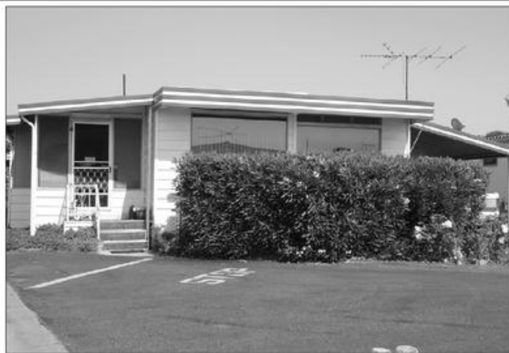
Hình chụp một căn mobile double wide được nối rộng, và phần nối rộng (expande) này nằm bên phía trái của căn nhà, được nâng lên cùng một độ cao với phần chính (double wide) của căn nhà bằng một hệ thống con dọi.
