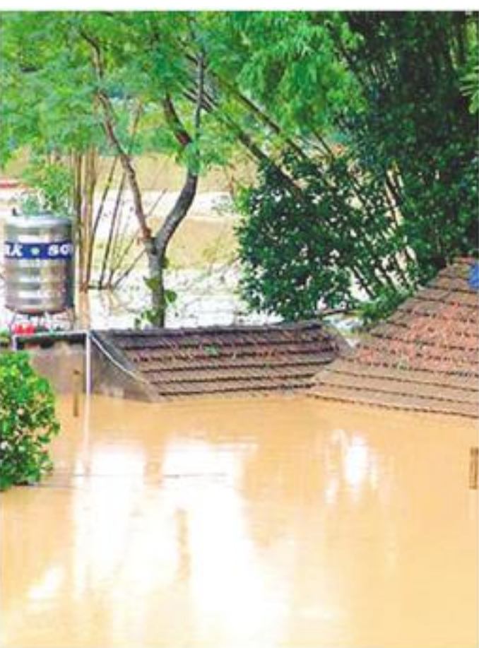
Nhà ở thành phố Yên Bái bị ngập lên tới nóc.
