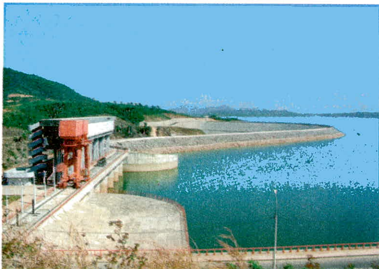
Hình 5. Thủy điện Y-a-li
