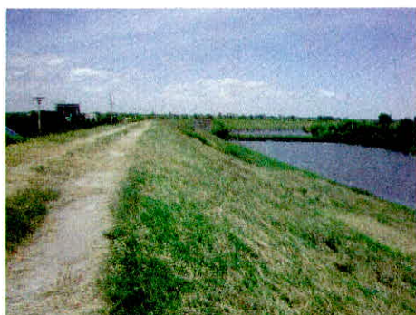
Hình 3. Một đoạn đê sông Hồng
