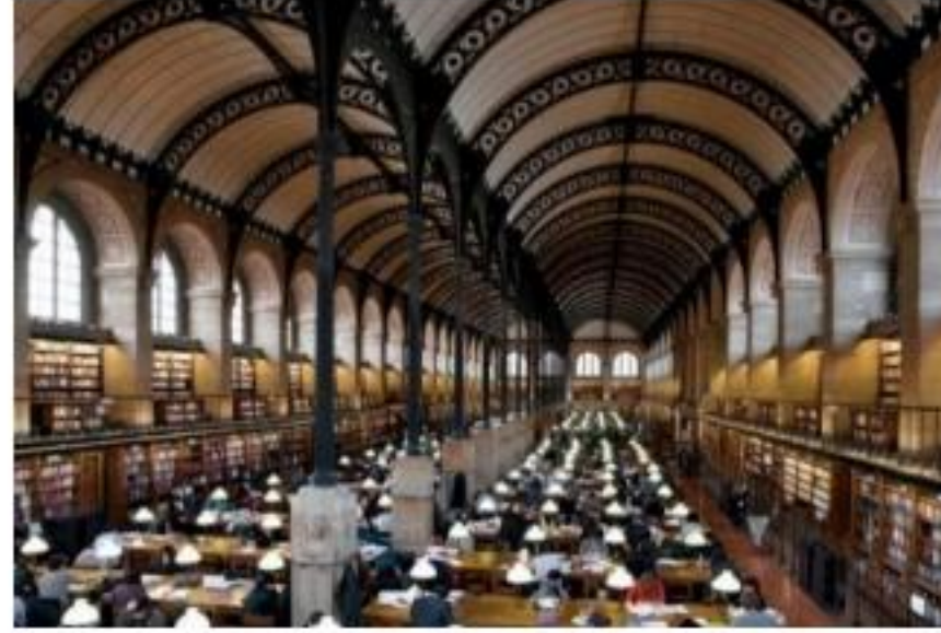
Hình 22 Kết cấu vòm thép
