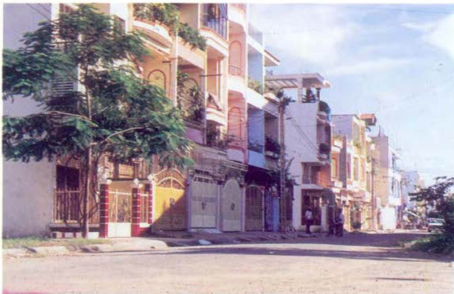
Một phần khu nhà dân cư Bình Phú - Quận 6 mới được xây dựng.
