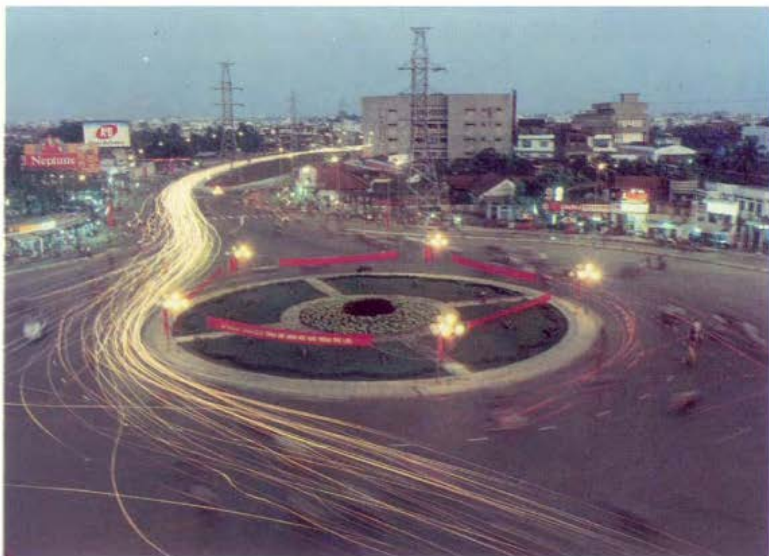
Vòng xoay nút giao thông Phú Lâm - Quận 6.
