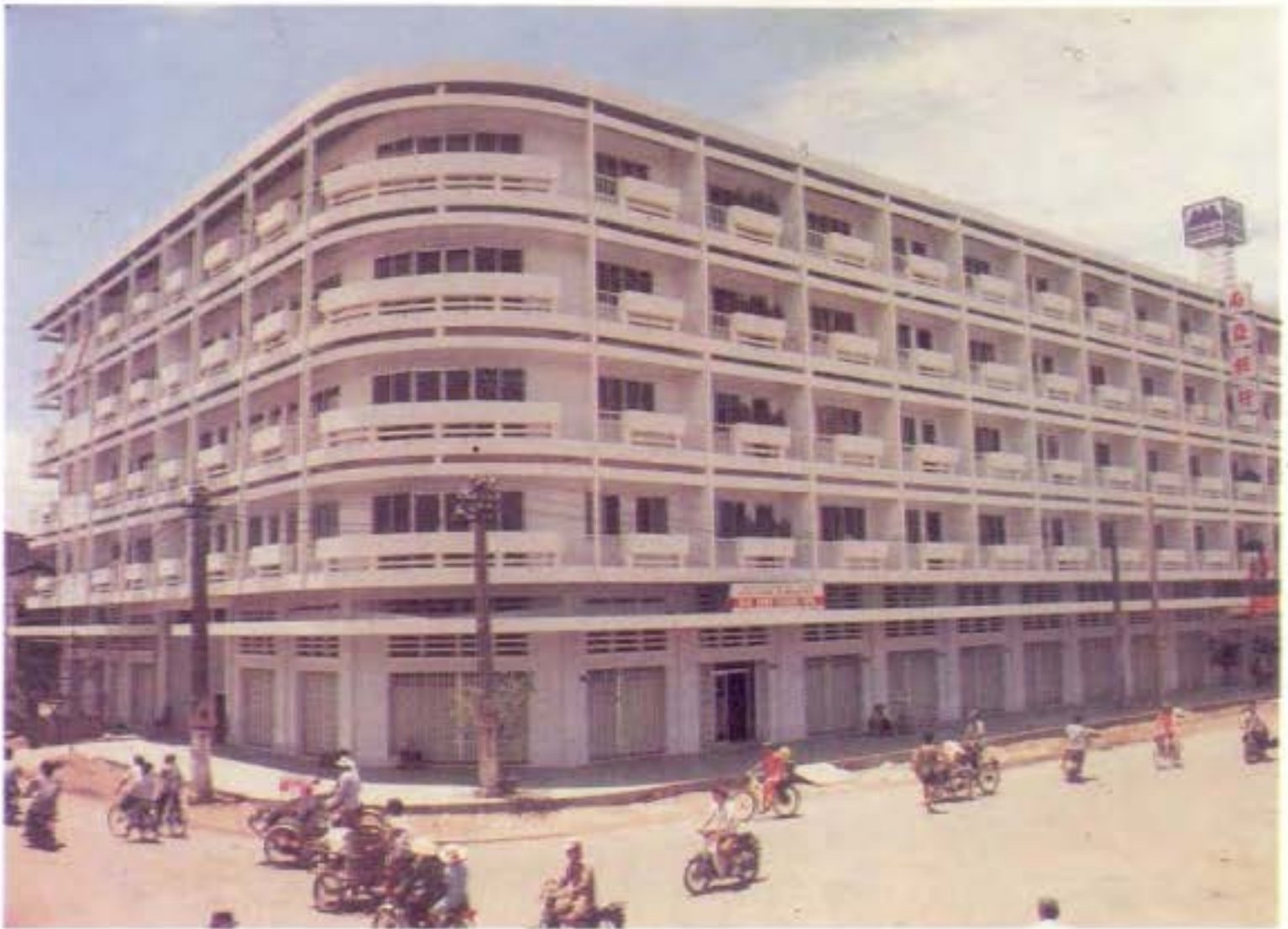
Khu thương mại và nhà ở Bình Tây - Quận 6 xây dựng hoàn thành năm 1993.
