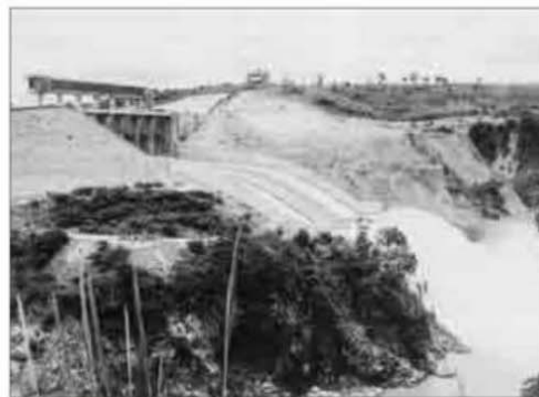
Hình 86. Công trình thủy điện Y-a-ly
